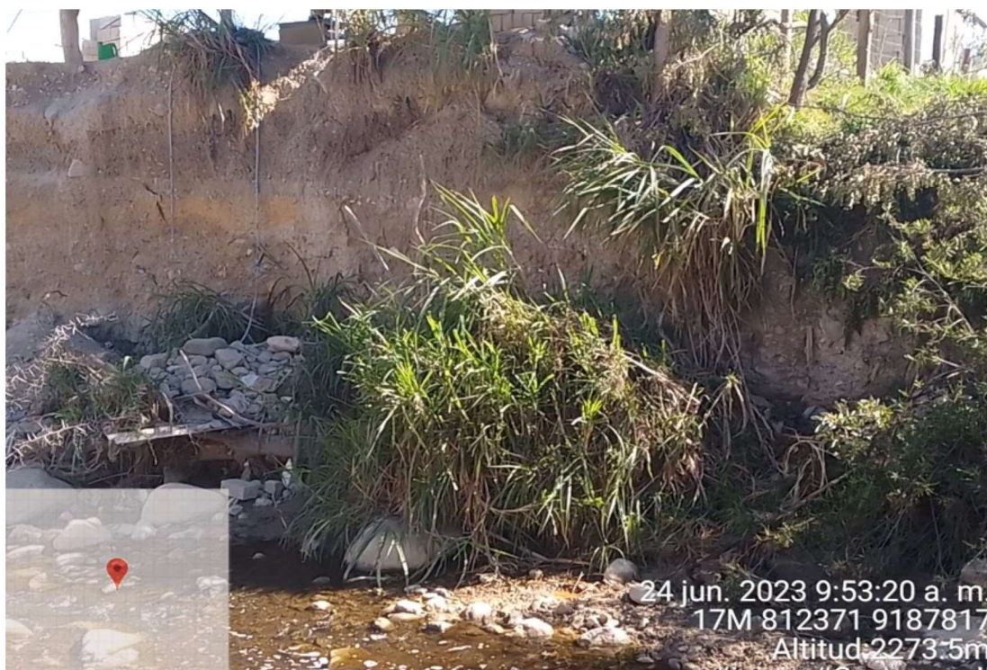
FOTO 04 : En la vista se observa la margen derecha del rio, de material suelto próximo a erosionar debido a su conformación de material suelto
